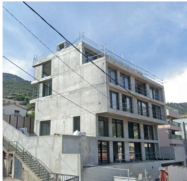
Gestion de la façade
